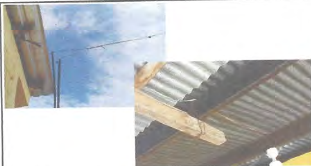
Foto: 3 Sustrucción de ducto eléctrico más accesorios
