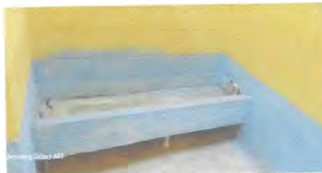
Foto: 4 Suministro de instalación de migitorio
