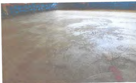
Foto: 2 sustitucion piso torta de cemento
