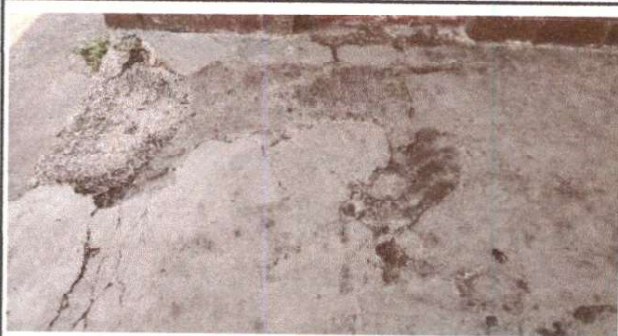
REPARACION DE BANQUETA DE CONCRETO
