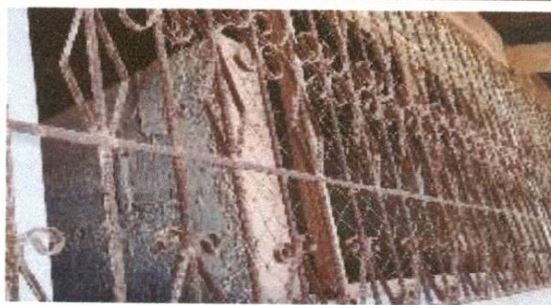
SUSTITUCIÓN DE BALCON DE METAL
