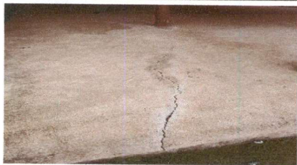
SUSTITUCION DE TORTA DE CONCRETO
