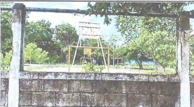
Foto 4: Reparación de tubo hg y malla galvanizada
