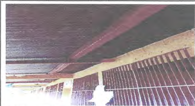
Foto 3: Mantenimiento a estructura de soporte de metal
