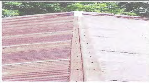
Foto 2: Sustrucción de capote de lámina para lámina troquelada
