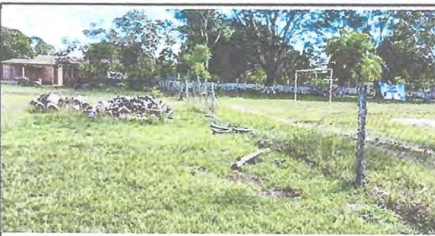
Foto 5: Reparación de tubo hg y malla galvanizada
