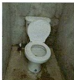
Foto 5: SERVICIOS SANITARIOS Y SUS ACCESORIOS, Sustitución de accesorios inodoro (contra llave, tubo de abasto y tanque), Sustitución de llave en mingitorio.
