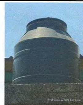
Foto 6: REPARACION Y MANTENIMIENTO DE CISTERNAS / DEPÓSITOS DE AGUA: Sustitución de depósito de agua 1100 lt
