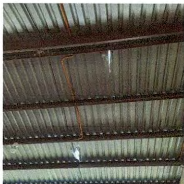
Foto 1: CUBIERTA DE LAMINA, sustitución de 3 laminas.
