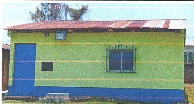
FOT1 SUSTITUCIÓN DE LAMINA TROQUELADA ALUZIN CALIBRE 26. 1.1
