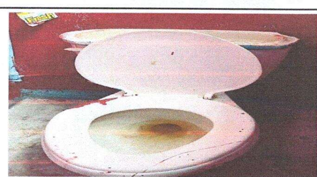
FOTO 6. SUSTITUCION DE INODOROS 10.3
