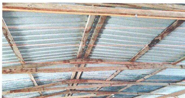
FOTO 4 SUSTITUCION DE ESTRUCTURA DE SOPORTE DE MADERA, POR METAL
