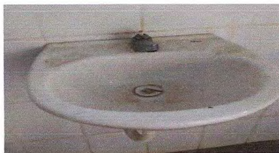
FOTO 2. SUSTITUCION DE LAVAMANOS
