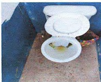
FOTO 1. SUSTITUCION DE INODOROS
