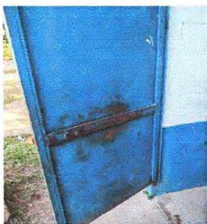
FOTO 7 MANTENIMIENTO A ESTRUCTURA lijado, cepillado, cambio de tubo, sujeción, aplicación de pintura
