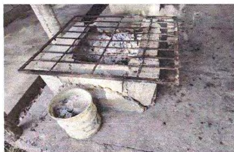
FOTO 8. MANTENIMIENTO A ESTUFA RURAL
