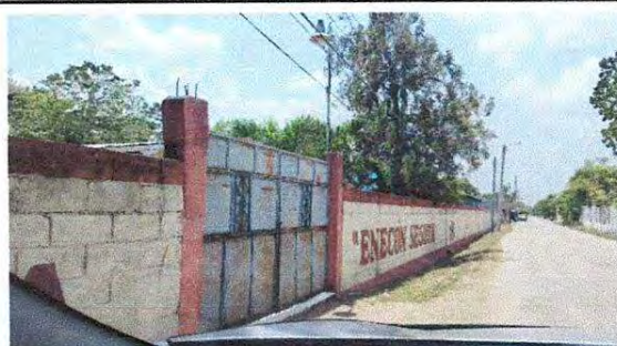
FOTO 6. SUSTITUCION DE PORTON
