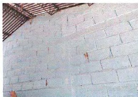
FOTO 10. PINTURA EN MURO EXTERIOR E INTERIOR
