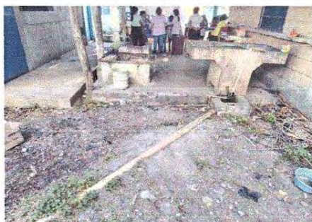
FOTO 15 SUSTITUCION DE TORTA DE CONCRETO
