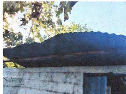
FOTO 14 SUSTITUCION DE ESTRUCTURA DE SOPORTE DE MADERA, POR METAL
