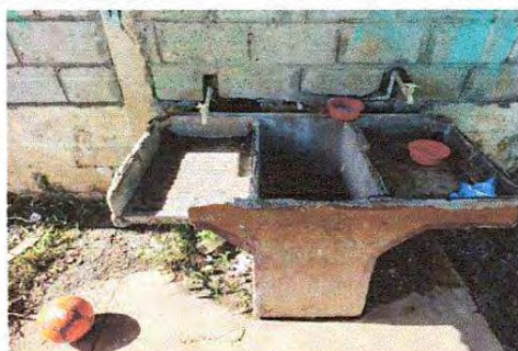
FOTO 9. SUSTITUCION DE PILA DE 2 LAVADEROS
