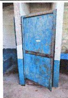
FOTO 4. SUSTITUCION DE PUERTA EN SERVICIO SANITARIO
