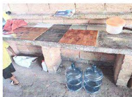
FOTO 16. REPARACIÓN DE AZULEJO EN MUEBLE DDE COCINA
