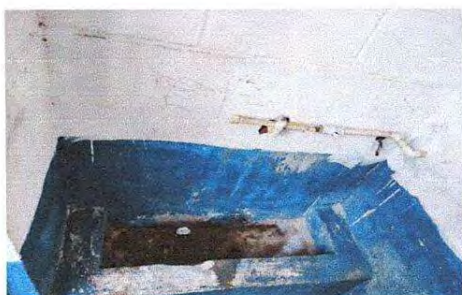
FOTO 3. SUSTITUCION DE MIGITORIO
