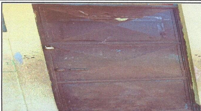
Foto 2: Sustitución de chapa
