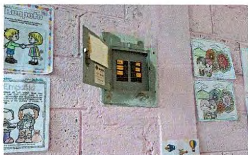
Foto 1: Sustitución de tablero de flípones
