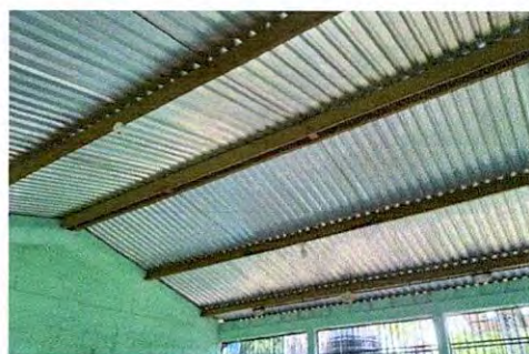
Foto 6: Sustitución de plafoneras
