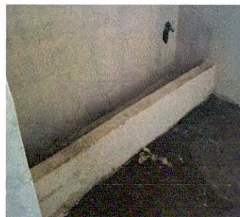
Foto 4: Sustitución de mingitorio
