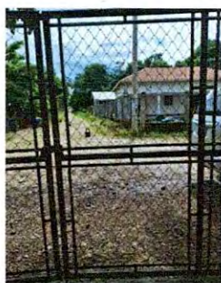
Foto 5: Mantenimiento a portones de metal
