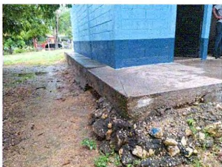
Foto 1: Reparación de piso de torta de concreto
