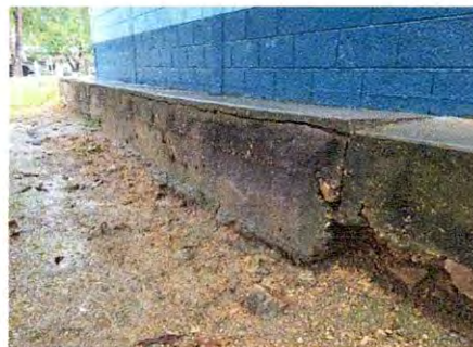
Foto 2: Reparación de muro de contención
