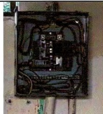
Foto 4: Instalación de tablero y flipones
