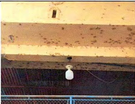
Foto 5: Sustrución de lamparas tipo LED
