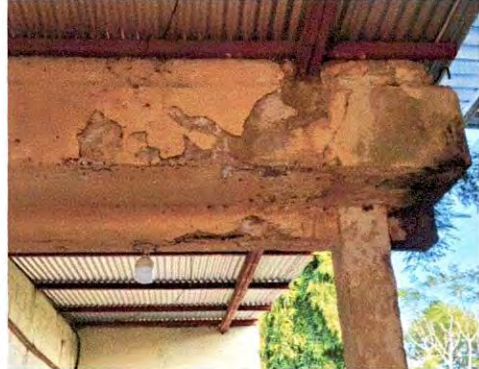
Foto 2: Repello en muro
