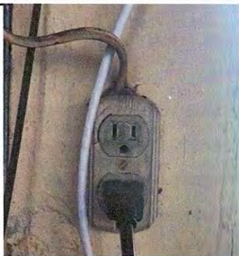
Foto 7: Instalación de unidades fuerza (tomacorriente), incluye cable eléctrico
