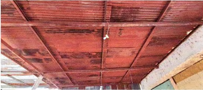
Foto 1: Sustrución de lámina, por lámina troquelada aluzinc calibre 26
