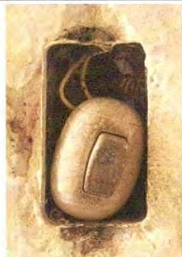
Foto 8: Instalación de unidades luz (incluye interruptor, ducto y cable eléctrico)
