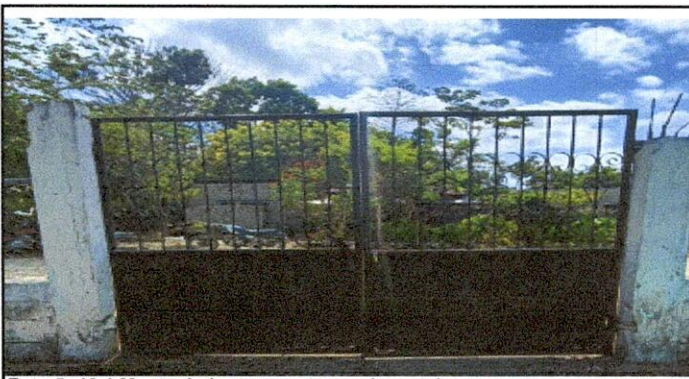
Foto 5: 12.1 Mantenimiento a portones de metal
