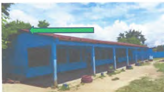
Foto: 2 Sustitución de capote de lámina troquelada y Sustitución de elemento de fijación.
