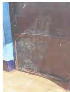
FOTO 10: Sustrucción, fabricación e instalación de puerta de metal por metal
