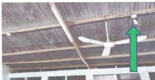
Foto: 6 Sustitución de focos ahorradores
