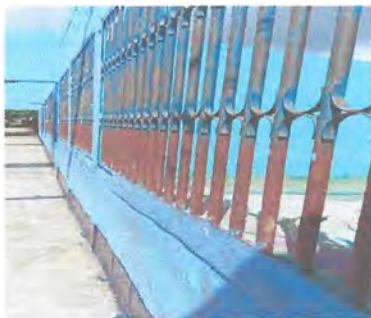
FOTO 11: Mantenimiento de balcones de metal
