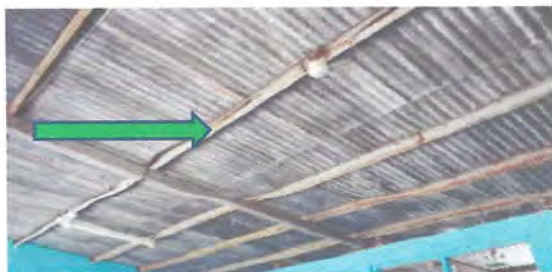
Foto: 5 Sustitución de ducto eléctrico +accesorios
