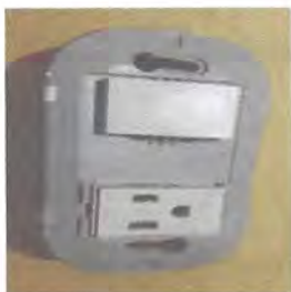
FOTO 9: Sustrucción interruptores dobles
