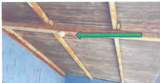
FOTO 7: Sustrucción de plafoneras
