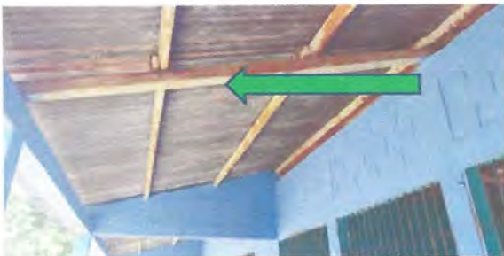
Foto: 3 Sustitución de estructura de soporte de metal por metal
