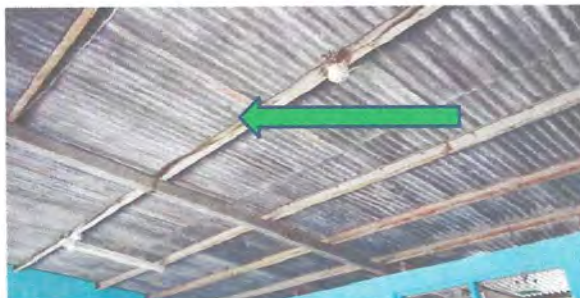
Foto: 4 Reparación de cableado eléctrico.
