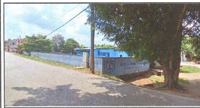
Foto 11: Reparación de muro perimetral de block.
