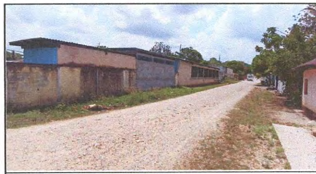
Reparación de muro perimetral de block.
