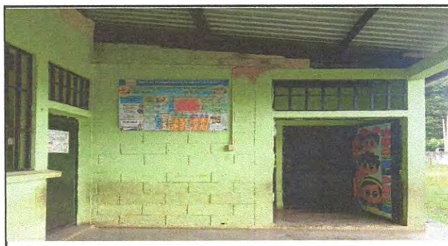
Foto 10: Pintura en muros exteriores e interiores
