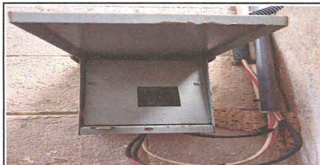
Foto 6: Sustitución de tablero de flipones
