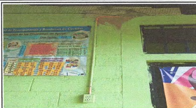
Foto 8: Sustitución de ducto eléctrico + accesorios
