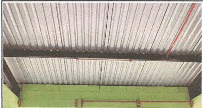
Foto 2: Sustitución de plafoneras
