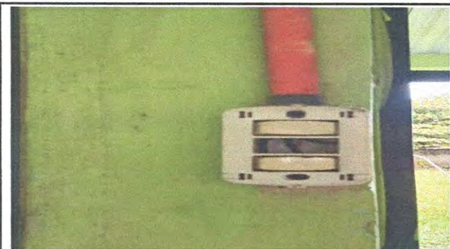
Foto 3: Sustitución interruptores dobles
