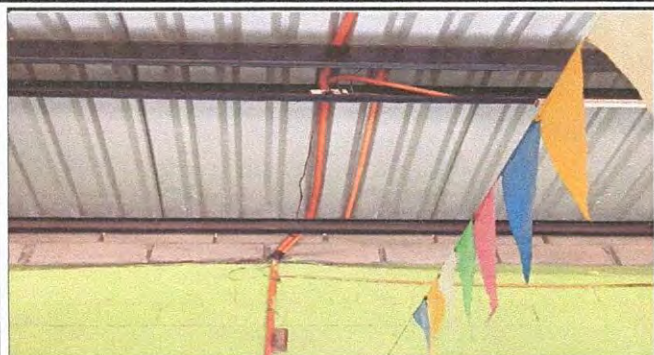
Foto 7: Reparación de cableado eléctrico
