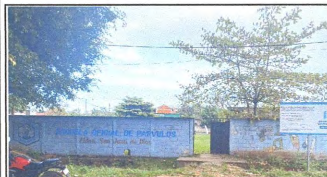
Foto 9: Pintura en muros exteriores e interiores
