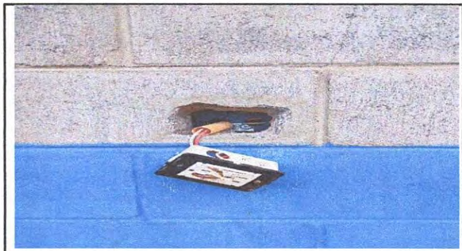
Foto 4: Sustitución de tomacorrientes dobles
