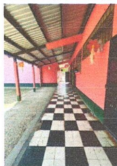
Foto 2 Sustitución de piso de torta de concreto
