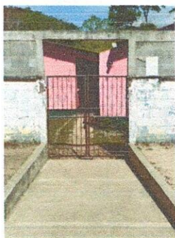
Foto: 3 Sustitución de portón de metal
