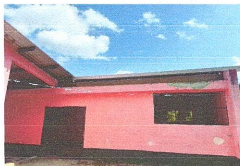
Foto: 6 Sustitución de canal de metal
