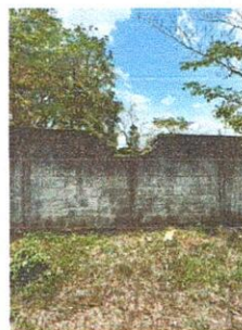
Foto: 4 Reparación de muro perimetral de block
