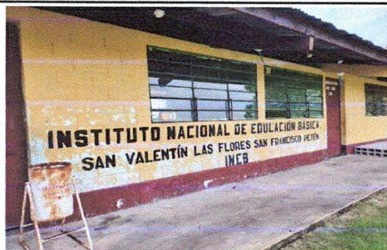
PINTURA EN MURO EXTERIOR E INTERIOR
