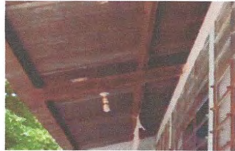
Foto 2: Sustitución de ducto eléctrico + accesorios
