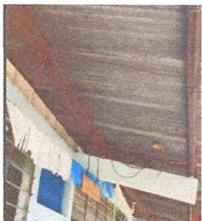
Foto 1: Sustrución de lámina, por lámina troquelada aluzinc calibre 26
