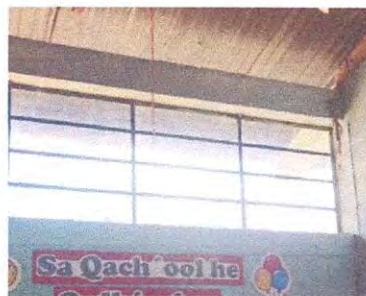
Foto 4: Suministro de ventanas con marcos de aluminio mill finish y paletas de vidrio
