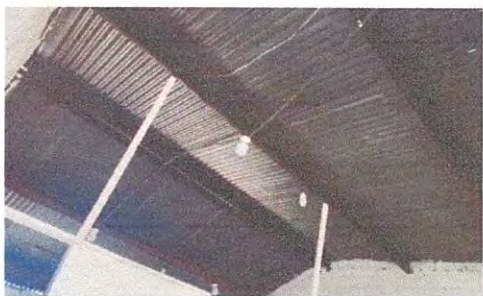
Foto 5: Reparación de lámparas
