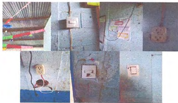
Foto 4: Sustitución de tomacorrientes dobles
