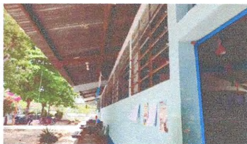
Foto 2: Mantenimiento a estructura de soporte de metal
