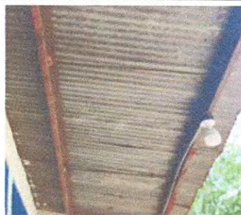
Foto 6: Sustrución de plafoneras
