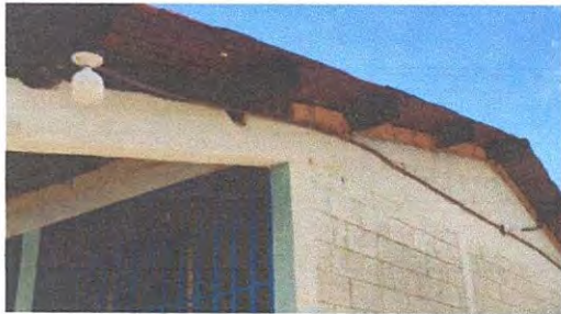
Foto 1: Reparación de cableado eléctrico
