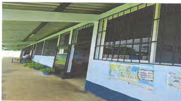
Foto: 3 Suministro de ventna PVC
