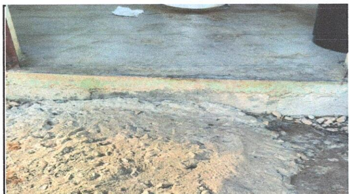
Reparación de piso de torta de concreto
