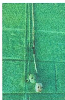
Sustitución interruptores simples
