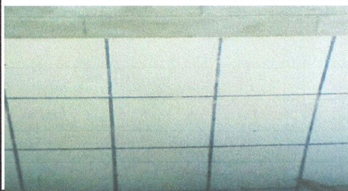
Sustitución de piso cerámico
