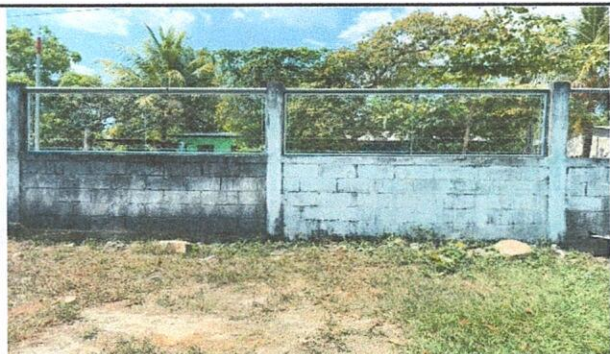
Pintura en muros exteriores e interiores
