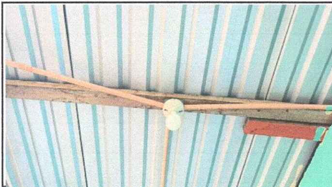
Sustitución de focos ahorradores
