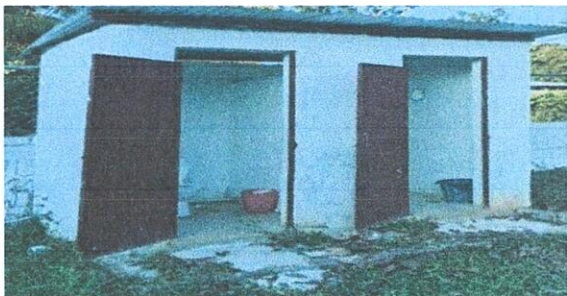
Sustitución de puerta de metal en servicios sanitarios
