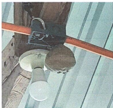
Sustitución de plafoneras
