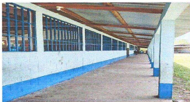
FOTO 3. PINTURA EN MUROS EXTERIORES E INTERIORES
