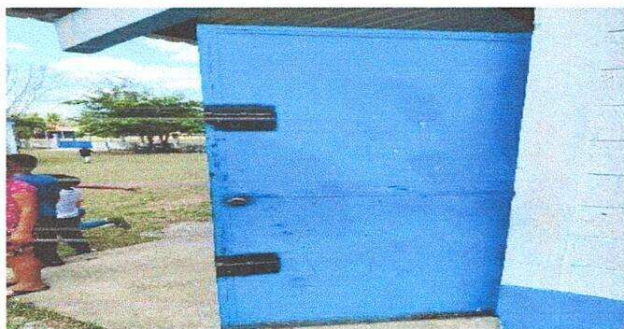
FOTO 1. MANTENIMIENTO A ESTRUCTURA,
