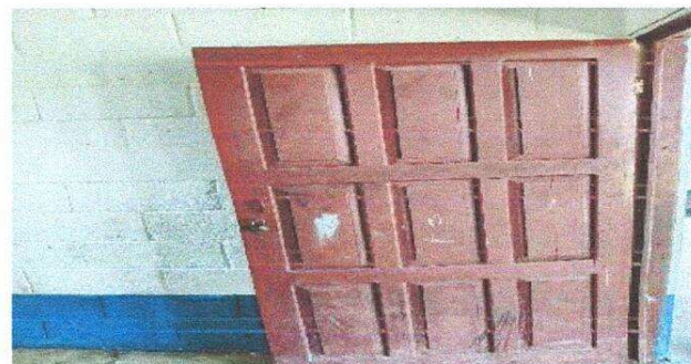
FOTO 2. SUSTITUCION DE PUERTAS
