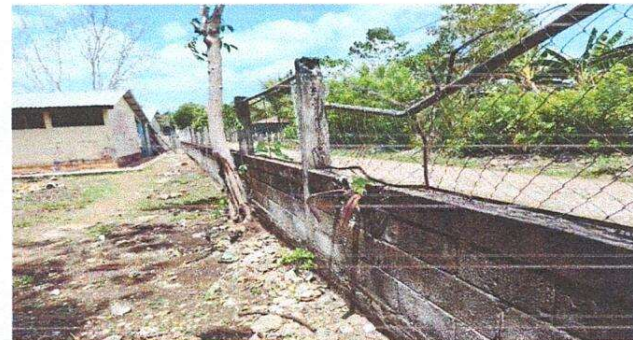
FOTO 4. REPARACION DE TUBO HG Y MALLA GALVANIZADA
