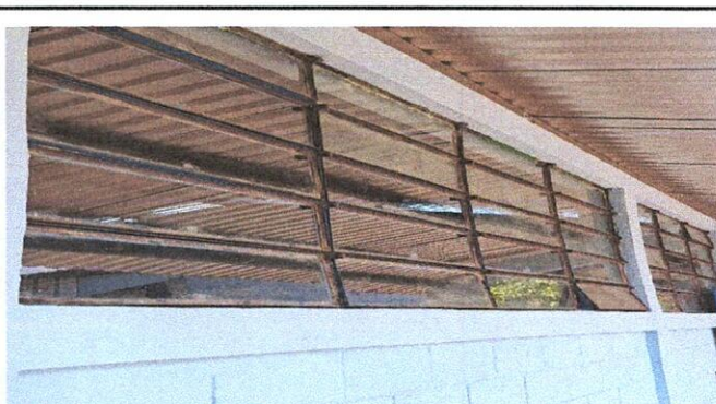
Foto: 4 Sustitucion de ventanas de metal
