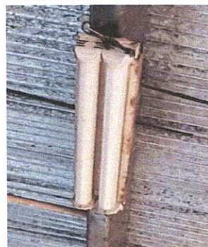
Foto 10: Sustrucion de cableado electrico
