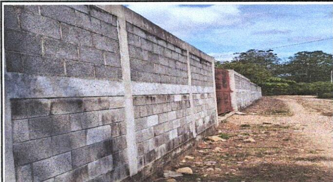
Foto 11: Pintura de muro perimetral de block
