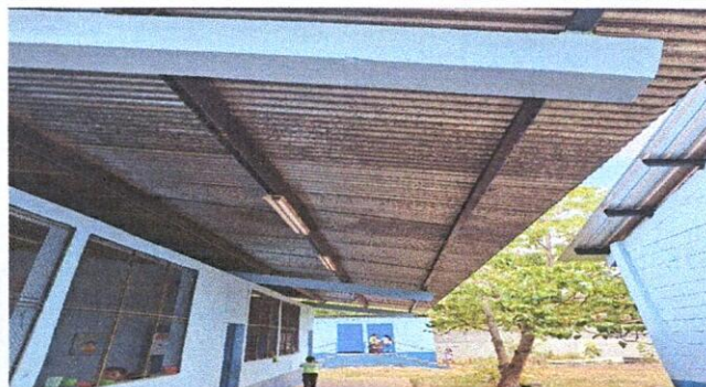
foto 2: Mantenimiento a estructura de soporte de meteat
