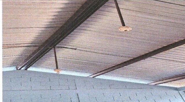
Foto: 6 Sustitucion de lamparas LED
