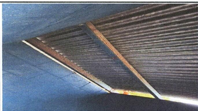
Foto: 3 Sustitucion de soporte de metal (baños)
