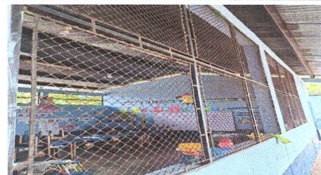
Foto: 5 Mantenimiento de ventanas de metal
