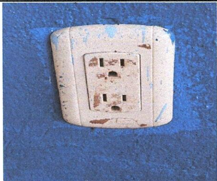
Foto 7: Sustrucion de tomacorrientes doble
