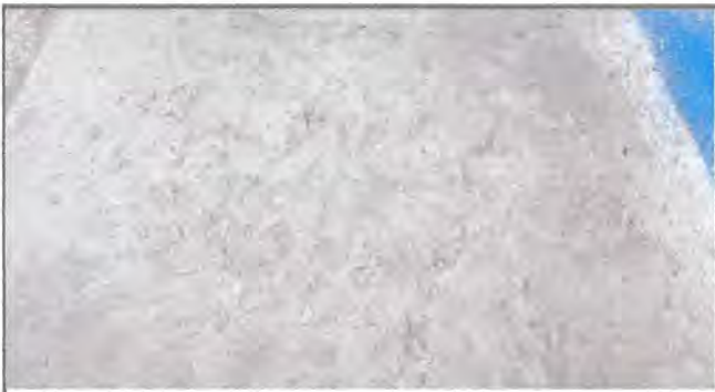
Foto 3: Sustitución de piso de torta de concreto
