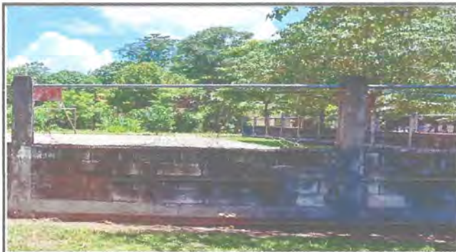
Foto: 4 Reparación de muro perimetral de block con tubo hg y malla galvanizada, soleras intermedias y columnas.
