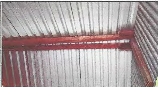
Foto 2 Sustitución de estructura de soporte de madera, por metal
