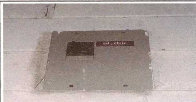
Foto 9: Sustrucción de tablero de filpones
