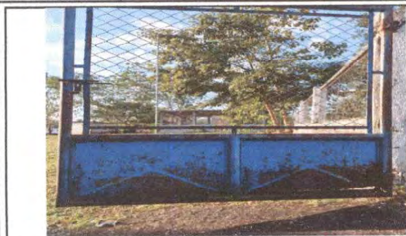
Foto14: Fabricación e instalación de portón de metal de ingreso
