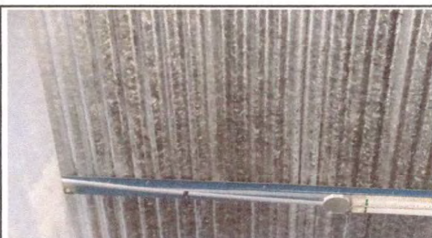
Foto 10: Sustrucción de ducto eléctrico + accesorios
