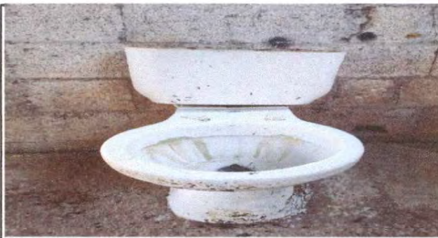
Foto 12: Sustrucción de inodoro
