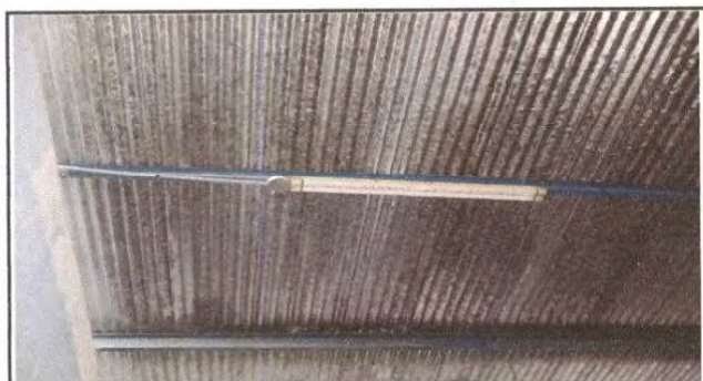
Foto 4: Sustitución de focos ahorradores
