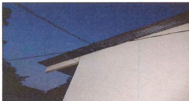
Foto 9: Reparación de cableado eléctrico
