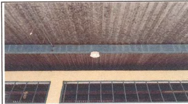
Foto 5: Sustitución de plafoneras
