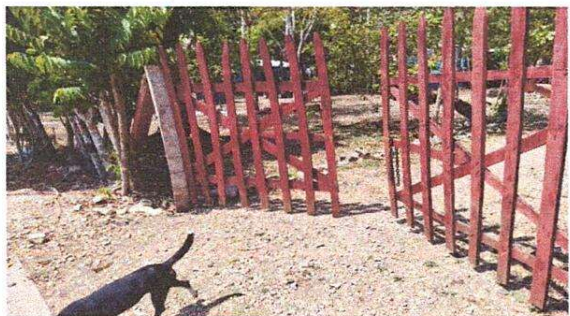
SUSTITUCION DE PORTON
