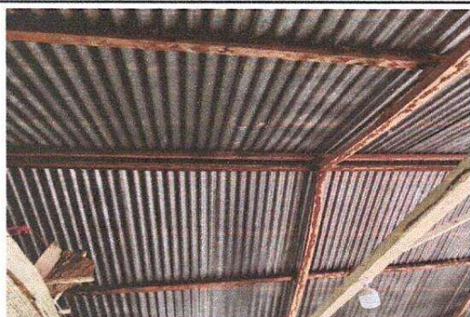
FOTO 7 SUSTITUCION DE ESTRUCTURA DE SOPORTE DE MADERA POR METAL
