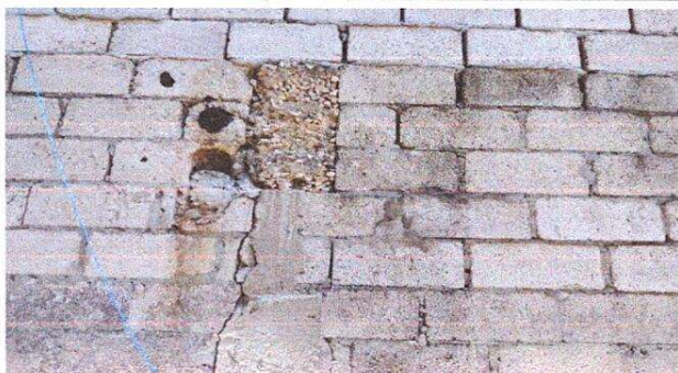
FOTO 9. REPELLO EN MURO
