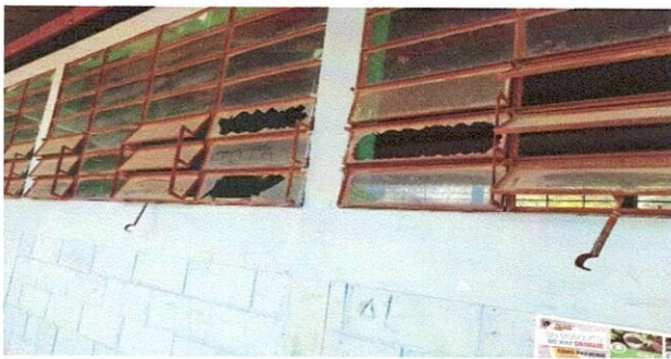
FOTO 9. SUSTITUCION DE BALCON DE METAL
