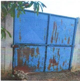
FOTO 1. MANTENIMIENTO A ESTRUCTURA lijado, sepillado, cambio de tubo, sujeciones y aplicación de pintura
