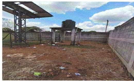
foto 2. sustitucion de deposito de agua
