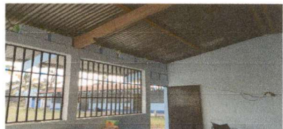
Foto 6: Reparación de cableado electrico.
