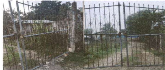
Foto 4: Mantenimiento a portones de metal.
