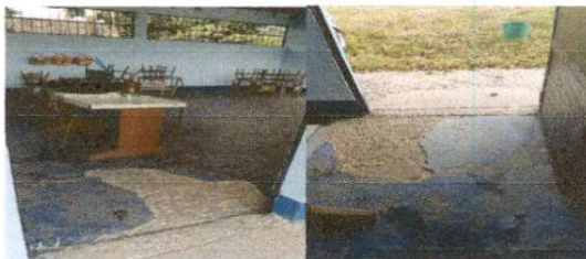
Foto 5: Sustrucción de piso de cemento líquido.
