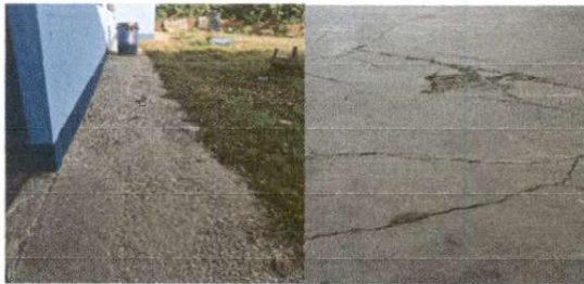
Foto 3: Reparación de piso de concreto.
