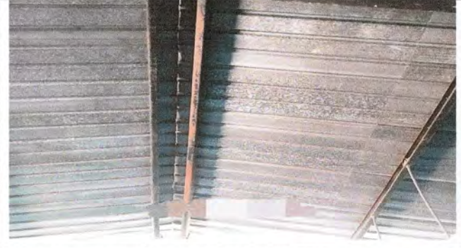
Foto 2: Mantenimiento a estructura de soporte de metal
