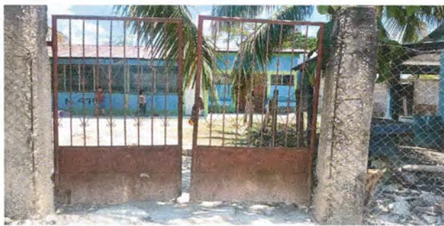
Foto 5: Sustrucción de portón de metal
