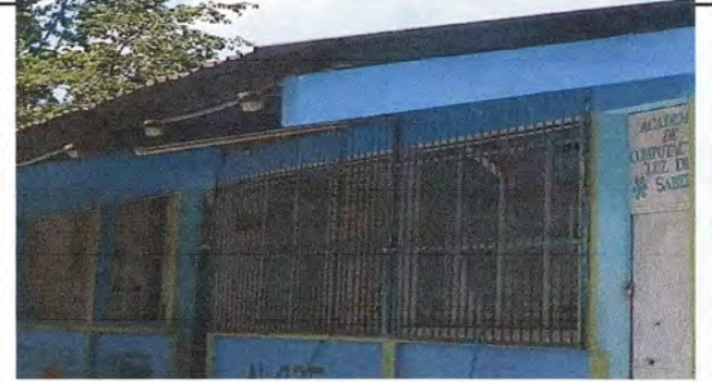
Foto 4: Mantenimiento a balcones de metal
