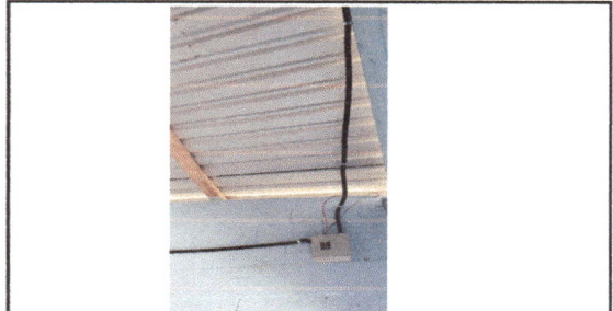
Foto 4: REPARACION DE SISTEMA ELÉCTRICO
