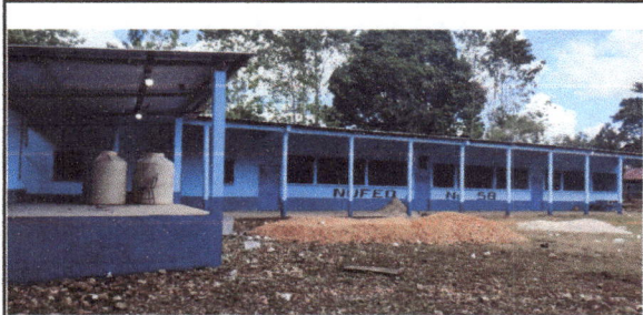
Foto 3: Pintura en muros exteriores e interiores
