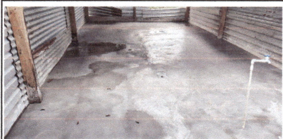
Foto 5: Reparación de piso de torta de concreto
