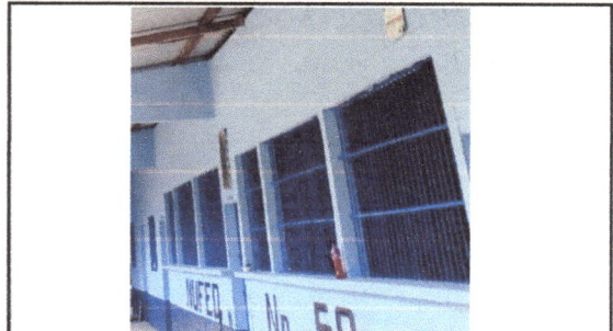
Foto 2: Mantenimiento a balcones de metal
