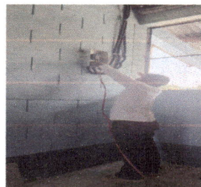
Foto 4: REPARACION DE SISTEMA ELÉCTRICO
