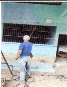
Foto 3: Pintura en muros exteriores e interiores
