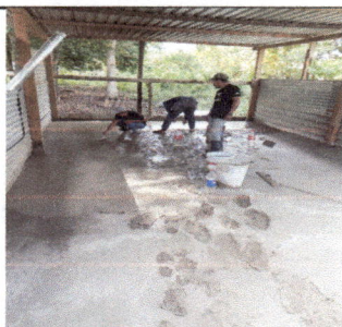
Foto 5: Reparación de piso de torta de concreto
