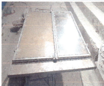
Foto 1: Sustrucción de puerta
