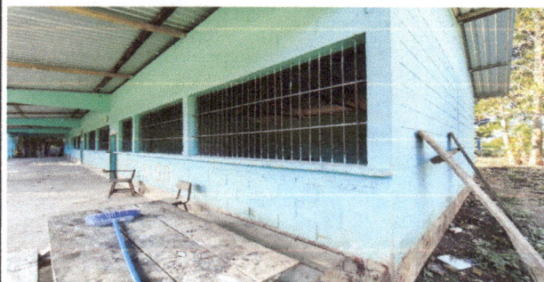
Foto 2: Mantenimiento a balcones de metal
