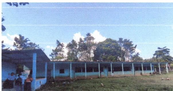
Foto 3: Pintura en muros exteriores e interiores
