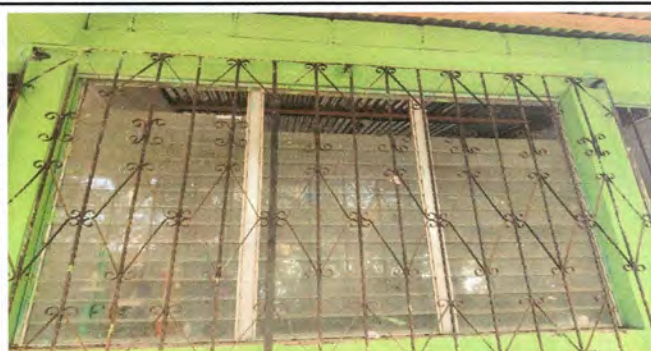
SUSTITUCION DE BALCON DE METAL POR METAL
