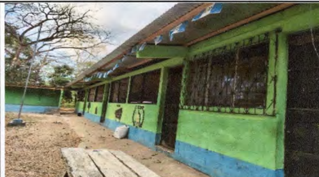
PINTURA EN MURO EXTERIOR E INTERIOR
