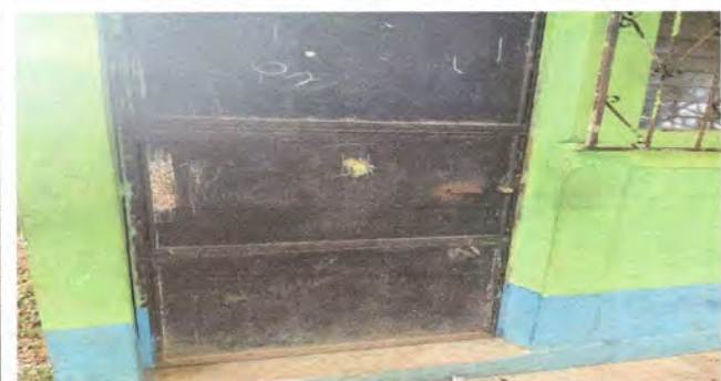
SUSTITUCIÓN DE PUERTAS
