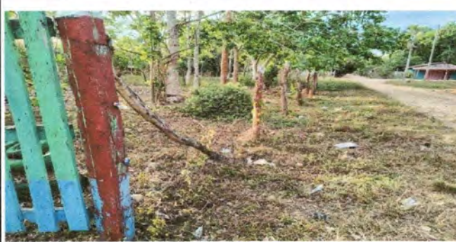
REPARACIÓN DE TUBO HG MALLA GALVANIZADA
