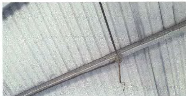
REPARACIÓN DE CABLEADO ELECTRICO
