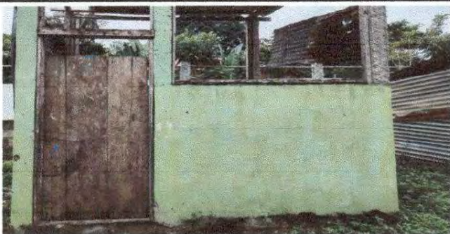
SUSTITUCION DE PUERTA
