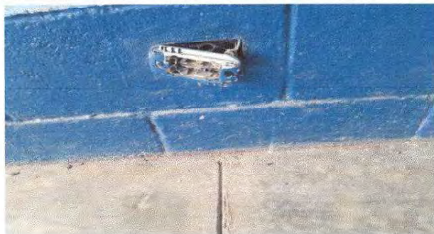
SUSTITUCIÓN DE TOMACORRIENTES DOBLES
