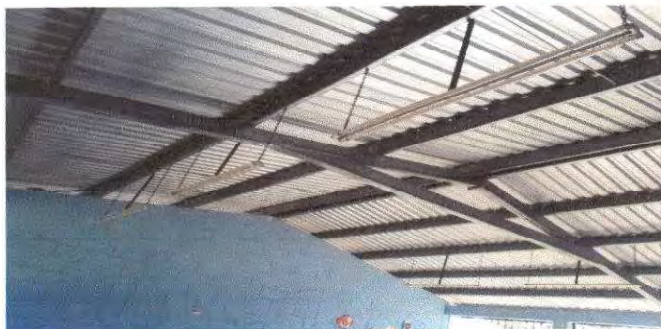
SUSTITUCIÓN DE CAPOTE DE LAMINA PARA LAMINA TROQUELADA
