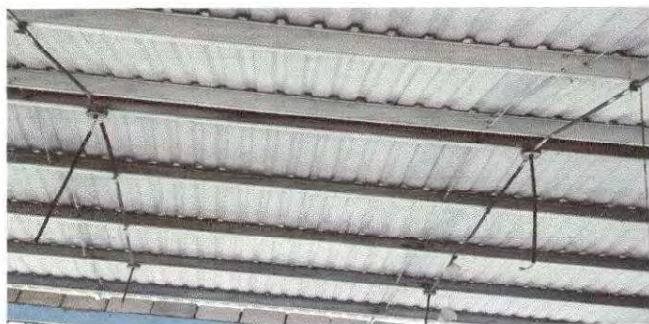
SUSTITUCION DE PLAFONERAS
