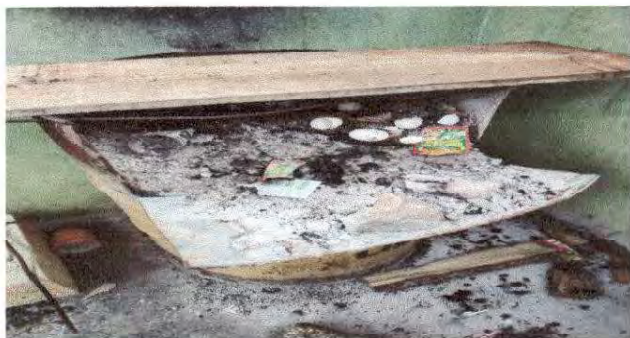
SUSTITUCIÓN DE COCINA RURAL
