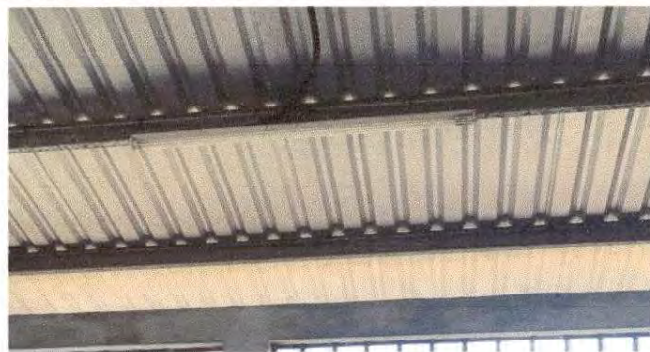
SUSTITUCIÓN DE FOCOS AHORRADORES
