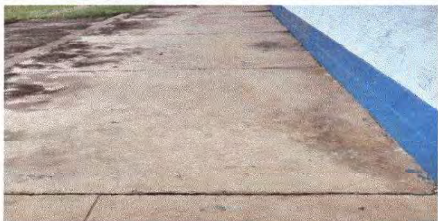
SUSTITUCIÓN DE PISO DE TORTA DE CONCRETO
