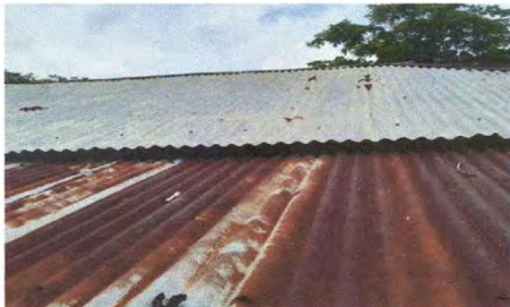
Foto1: 1 CUBIERTA DE LÁMINA. 1.1. Sustitución de lámina, por lámina troquelada aluzinc calibre 26. 19.8. Instalación de lámina troquelada aluzinc calibre 26. 19.10 Desinstalación de lámina existente.
