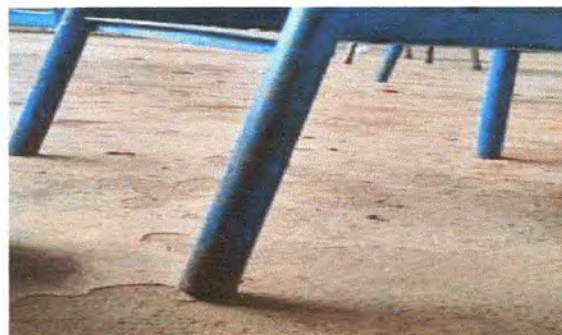
Foto 4: 6. PISO. 6.6. Sustitución de piso de cemento líquido.
