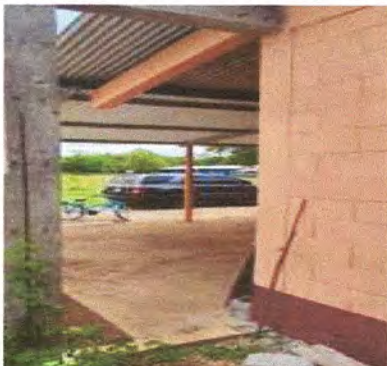
Foto1: 19.3. Fabricación e instalación de puertas en metal por módulo.
