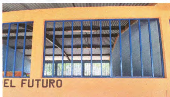
Foto 5: 19.1. Fabricación e instalación de ventana-balcon de metal.
