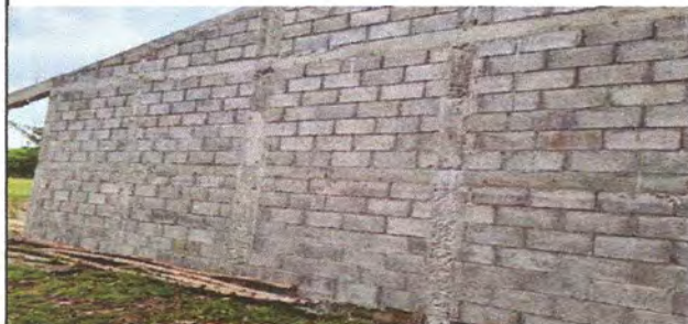
Foto 2; 21.1 Repello en muro. 21.2 Cernido en muro
