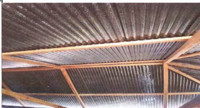
Foto 3: 2. ESTRUCTURA DE TECHO. 2.1. Sustitución de estructura de soporte de madera por metal.
