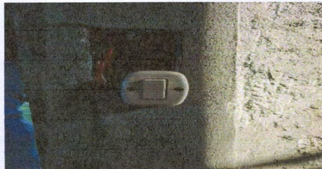
SUSTITUION DE INTERRUPTORES
