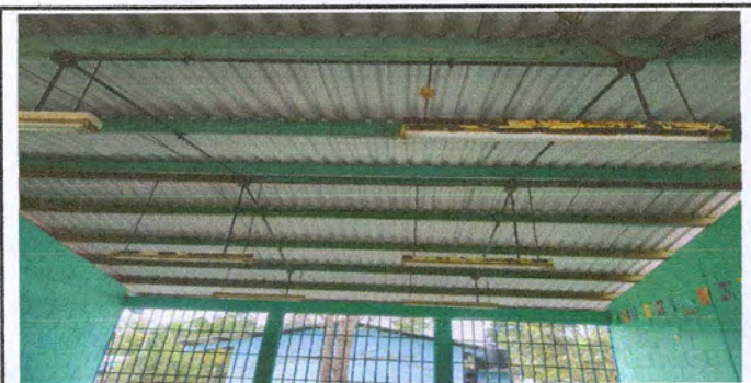
REPARACION DE CABLEADO ELÉCTRICO
