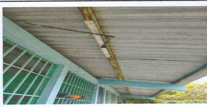
SUSTITUCION DE PLAFONERAS
