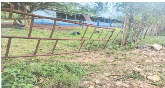
FOTO 1. SUSTITUCIÓN DE PORTON
