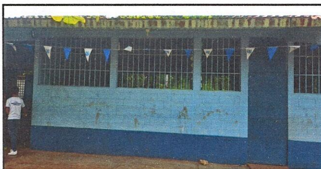
Foto 9: Mantenimiento a balcones de metal.
