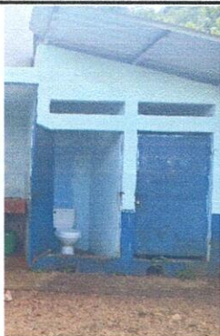
Foto 13: Sustitución de piso cerámico Servicios sanitarios
