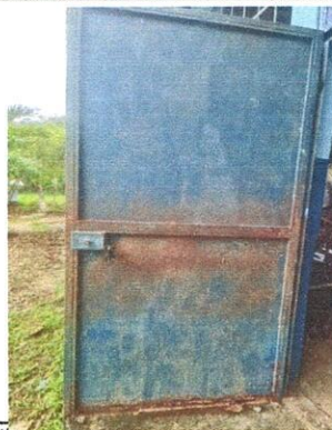
Foto 8 Sustrución de Puerta
