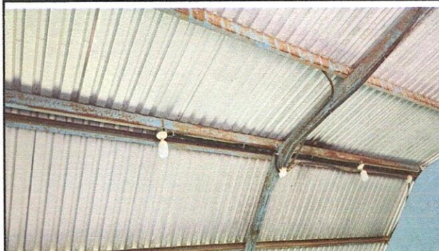
Foto: 4 Mantenimiento de estructura soporte de metal.
