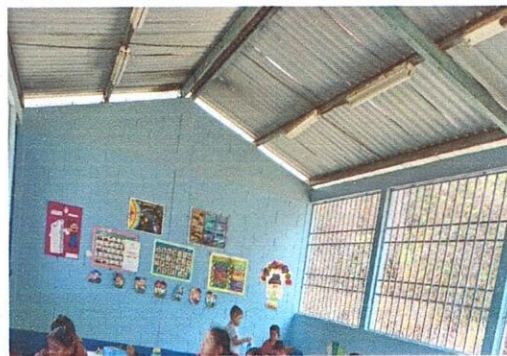
Foto 2 Sustitución de capote de lámina traquelada.
