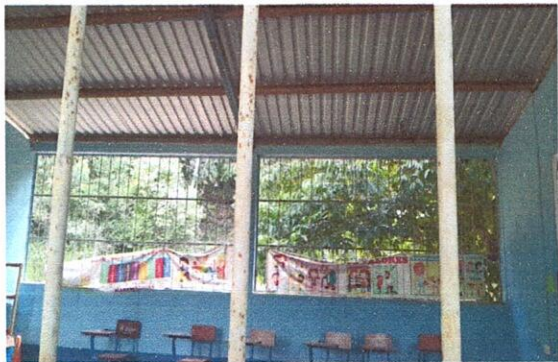
Foto 1: Sustitución de lámina por lámina traquelada aluzinc calibre 26.
