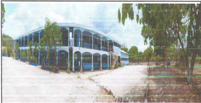
Foto1: Pintura en muros exteriores e interiores
