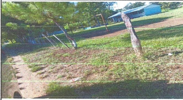
Foto 1: Sustitución de alambre de pua por malla galvanizada y tubo hg
