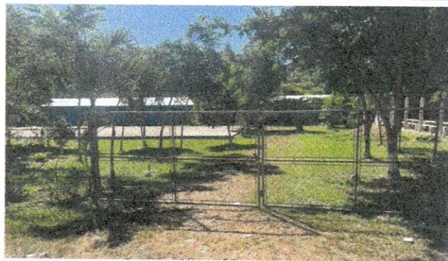
Foto 1: Mantenimiento de portones de de metal
