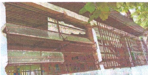
Foto 6: Sustitución de ventanas de madera por metal
