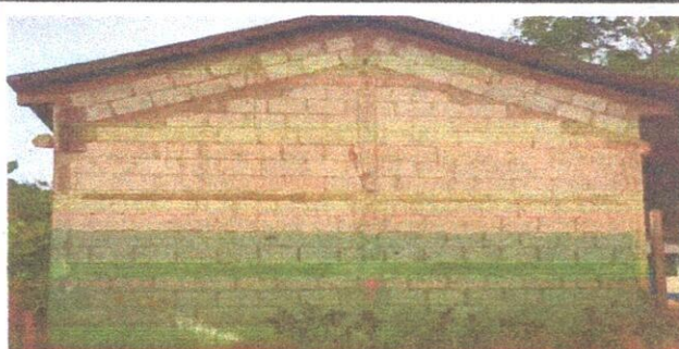
Foto 4: Reparación de muro perimetral de block.
