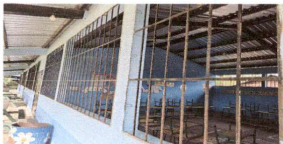
Foto1: MANTENIMIENTO A BALCONES DE METAL. Mantenimiento a balcones de metal
