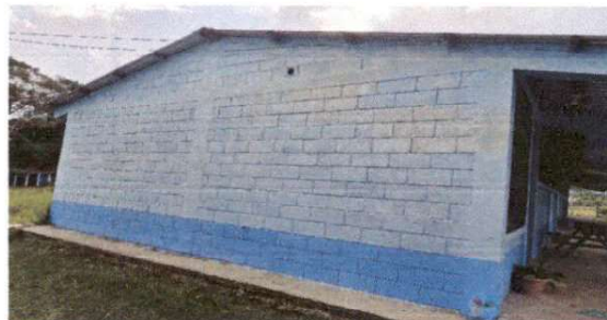
Foto 2: PINTURA EN MUROS EXTERIORES E INTERIORES. Pintura de muros exteriores e interiores de 7 aulas, dirección, cocinas, 2 bodegas, y 2 modulos de baño.
