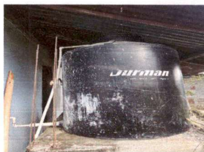
Foto 4: SUSTITUCION DE DEPOSITO DE AGUA. Sustitucion de deposito de agua de 1700 lt
