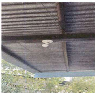
Foto 3: LUZ. Reparacion de alumbrado electrico: focos, plafoneras, interruptores, tomacorrientes, filpones y cable electrico.
