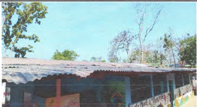
Foto1: Sustitución de lámina, por lámina troquelada aluzinc calibre 26 módulos de aulas y cocina
