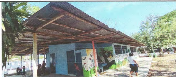
Foto 4: Sustitución de estructura de soporte de metal
