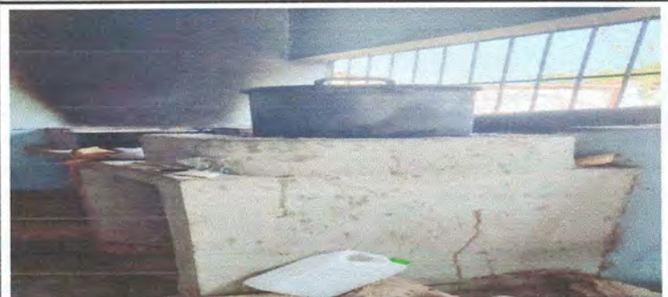
Foto 6: Sustitución de estufa rural (completa) incluye chimenea y plancha de metal
