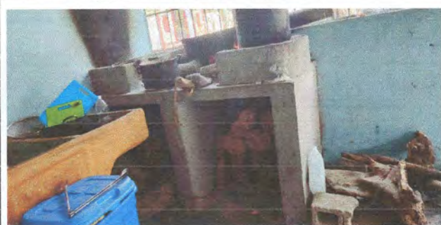
Foto 5: Instalación de azulejo en estufa rural
