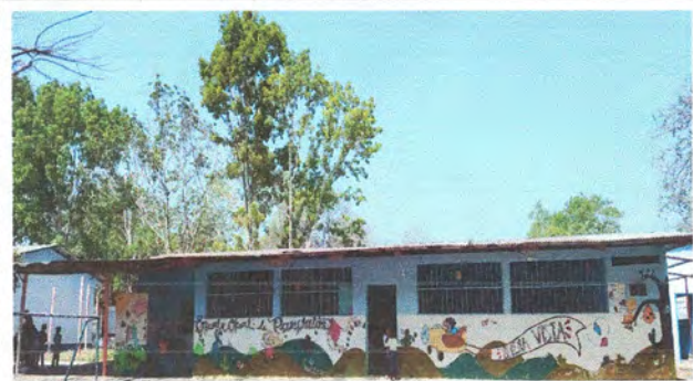
Foto 3: Sustitución de elementos de fijación
