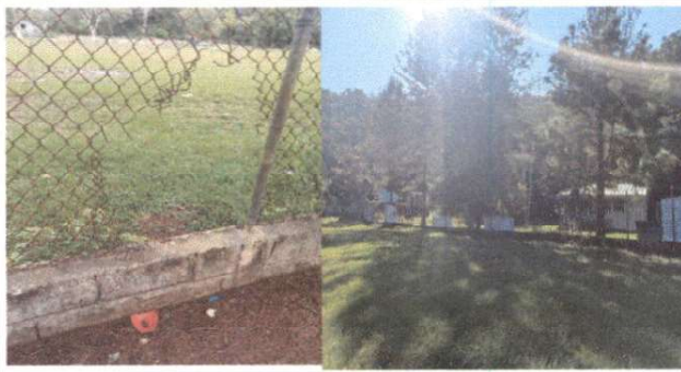
REPARACIÓN DE TUBO HG Y MALLA GALVANIZADA ✓
