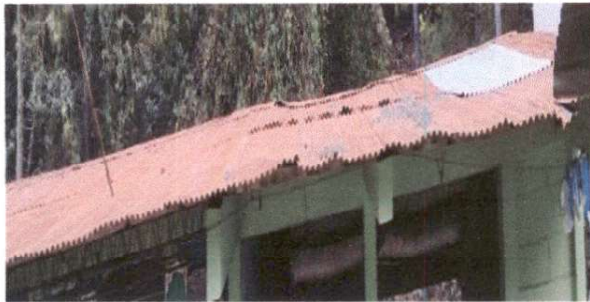
SUSTITUCION DE LAMINA, POR LAMINA TROQUELADA ALUZINC CALIBRE 26 ✓
