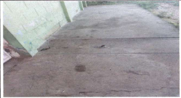
SUTITUCION DE PISO DE TORTA DE CONCRETO ✓
