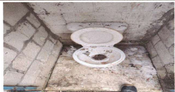
SUSTITUCION DE INODORO ✓
