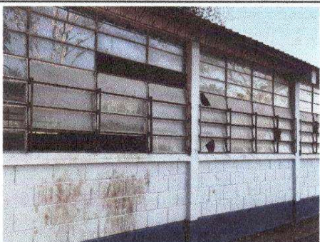
FOTO 2 - SUSTITUCIÓN DE BALCONES
