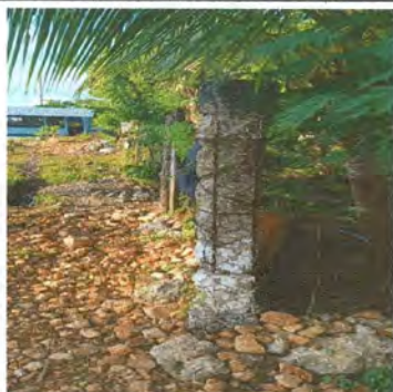
Foto 3: Reparación de tubo hg y malla galvanizada
