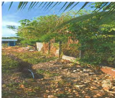
Foto 1: Reparación de tubo hg y malla galvanizada
