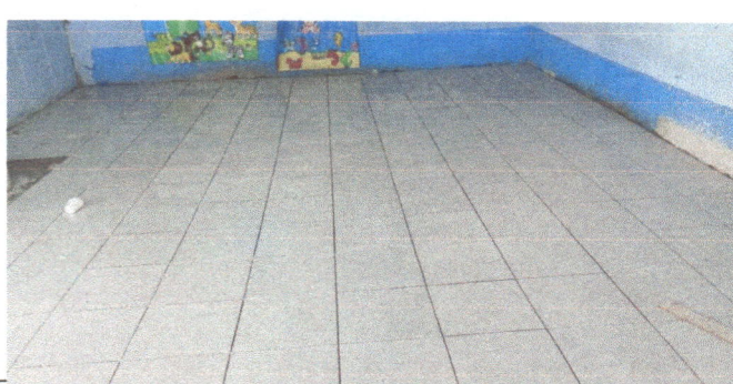
FOTO 6. MEJORAMIENTO DE PISO LISO POR CERAMICO
