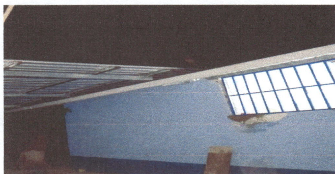
FOTO 7. SUSTITUCION DE CANAL DE PVC
