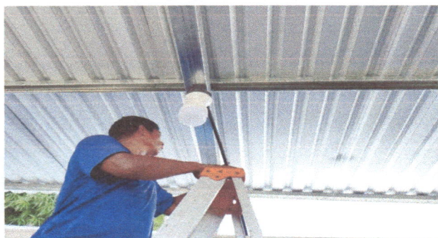
FOTO 9. SUSTITUCION DE FOCOS AHORRADORES
