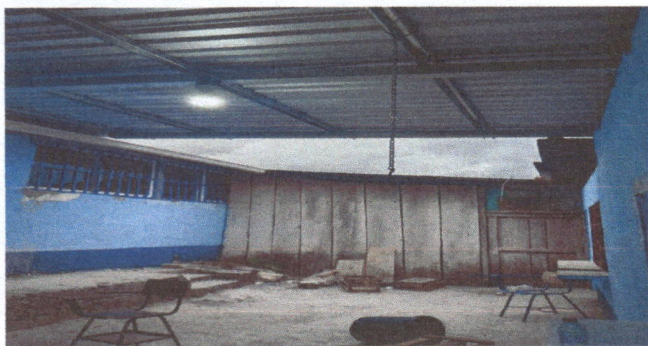
FOTO 13. SUSTITUCION DE CABLEADO ELCTRICO
