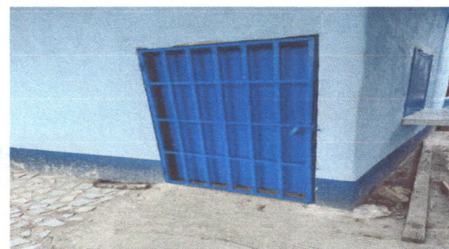
FOTO 3. SUSTITUCION DE PUERTAS
