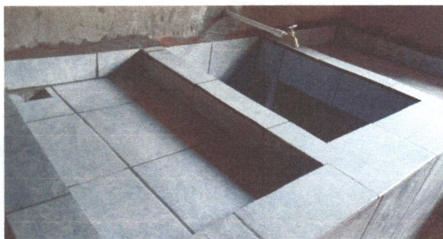
FOTO 15. SUSTITUCION DE PILA DE 2 LAVADEROS
