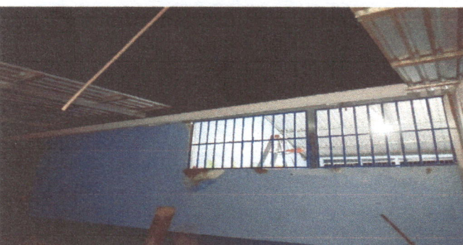
FOTO 5. SUSTITUCION DE BALCON DE METAL
