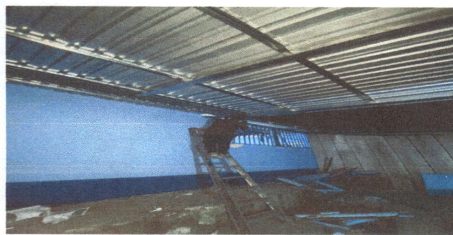
2. SUSTITUCION DE ESTRUCTURA DE SOPORTE DE MADERA, POR METAL
