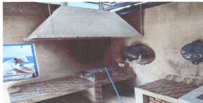
FOTO 14. SUSTITUCION DE ESTUFA RURAL
