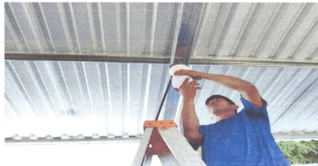
FOTO 10. SUSTITUCION DE PLAFONERAS
