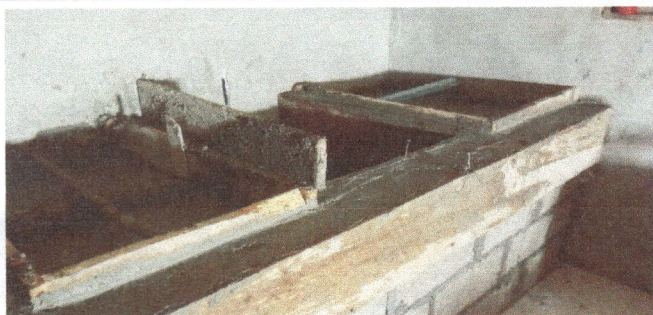
FOTO 15 SUSTITUCION DE PILA DE 2 LAVADEROS
