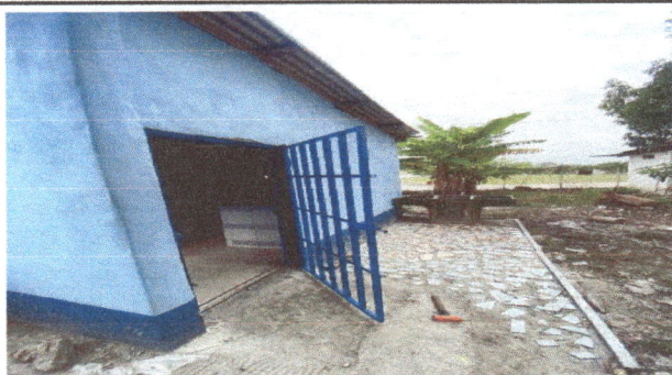
FOTO 5. SUSTITUCION DE BALCON DE METAL
