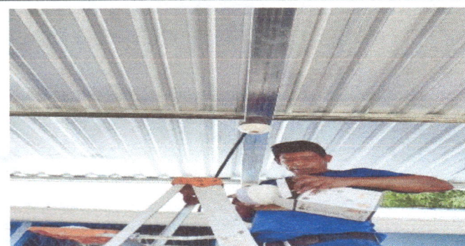
FOTO 9. SUSTITUCION DE FOCOS AHORRADORES
