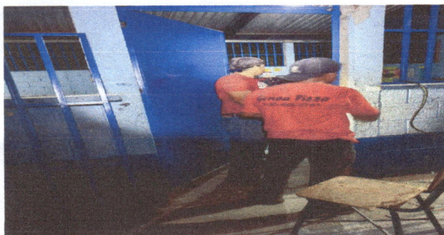
FOTO 3. SUSTITUCION DE PUERTAS
