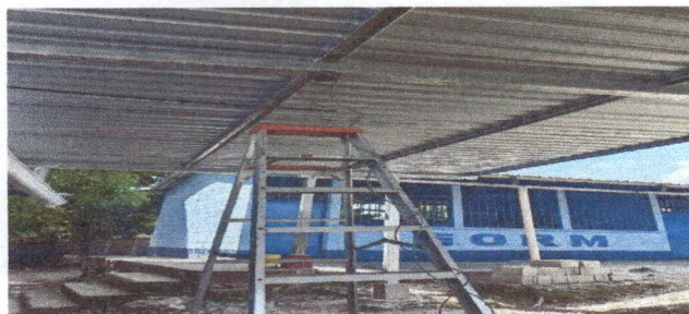
FOTO 13. SUSTITUCION DE CABLEADO ELECTRICO
