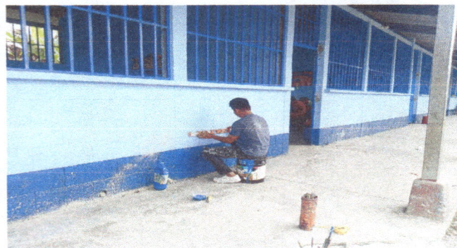
FOTO 8. PINTURA EN MUROS EXTERIORES E INTERIORES
