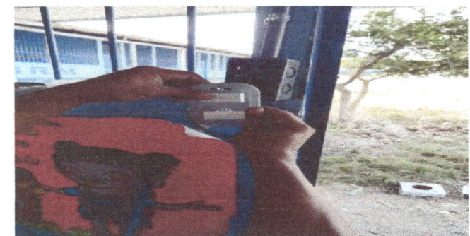
FOTO 11. SUSTITUCION DE INTERRUPTORES DOBLES
