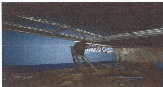
FOTO 7. SUSTITUCION DE CANAL DE PVC
