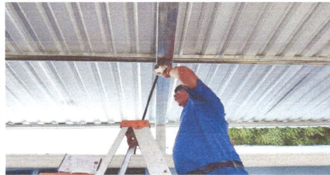
FOTO 10. SUSTITUCION DE PLAFONERAS
