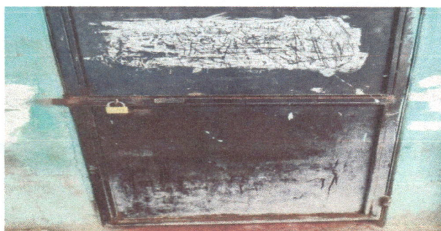
FOTO 3. SUSTITUCION DE PUERTAS
