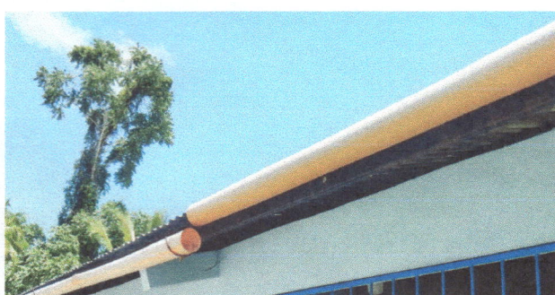
FOTO 7. SUSTITUCION DE CANAL DE PVC
