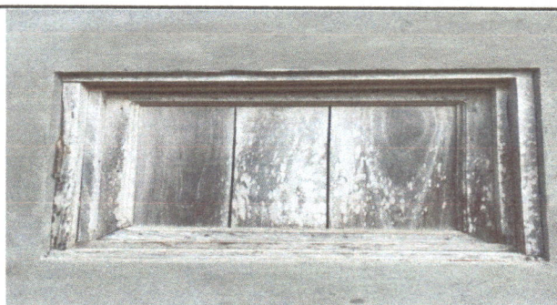
FOTO 4. SUSTITUCION DE VENTANAS DE MADERA, POR METAL MAS VIDRIO.
