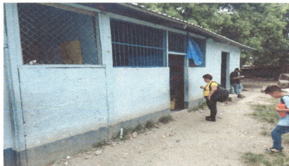
FOTO 8. PINTURA EN MUROS EXTERIORES E INTERIORES
