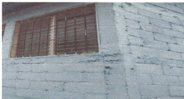
FOTO 5. SUSTITUCION DE BALCON DE METAL
