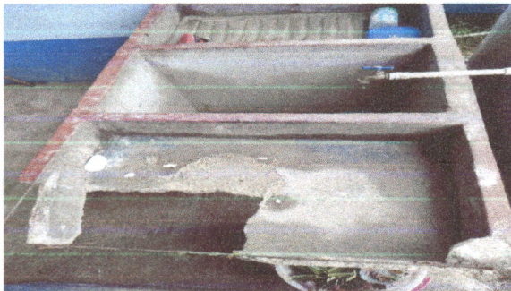
FOTO N 15 SUSTITUCION DE PILA DE CONCRETO DE 2 LAVADEROS
