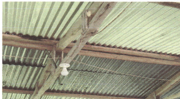
FOTO 10. SUSTITUCION DE PLAFONERAS
