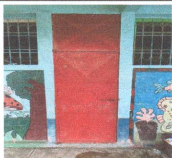
Foto 5: Sustrucción de puerta
