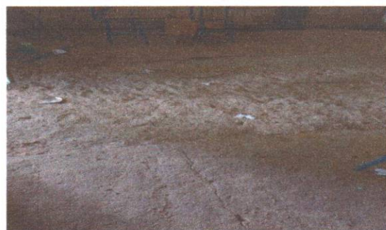
Foto 2: Sustrucción de piso de torta de concreto
