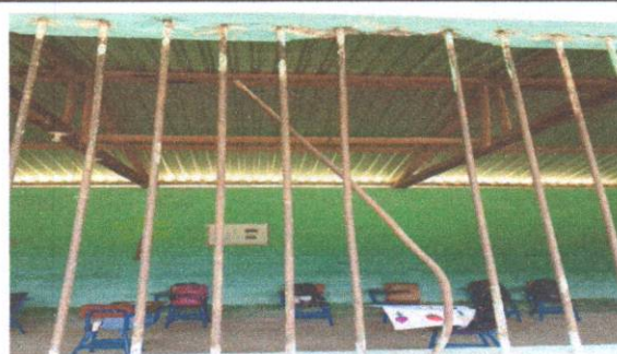
Foto 6: Sustrucción de ventanas de madera por metal
