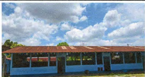
Foto1:Sustrucción de lamina, por lamina troquelada aluzinc calibre 26 modulo de aulas
