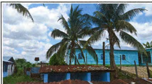
Foto 3:Sustrucción de lamina, por lamina troquelada aluzinc calibre 26 de baños
