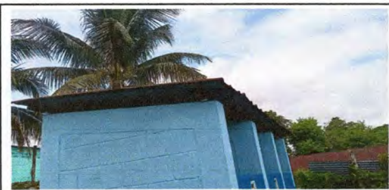
Foto 4:Sustrucción de estructura de soporte de metal, por metal
