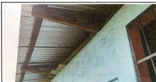
Foto 5:Sustrucción de estructura de soporte de madera, por metal
