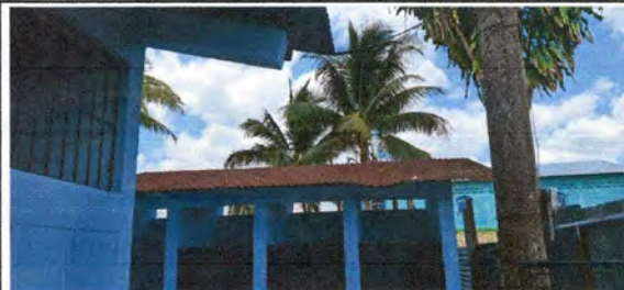
Foto 2:Sustrucción de lamina, por lamina troquelada aluzinc calibre 26 de baños
