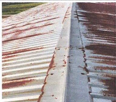
Foto 3: Sustitución de capote de lamina.
