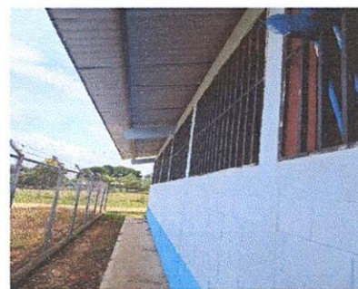
Foto 6: Sustitución de balcones de metal.
