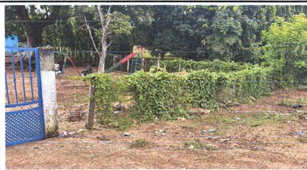
Foto 2: Reparación de tubo hg y malla galvanizada
